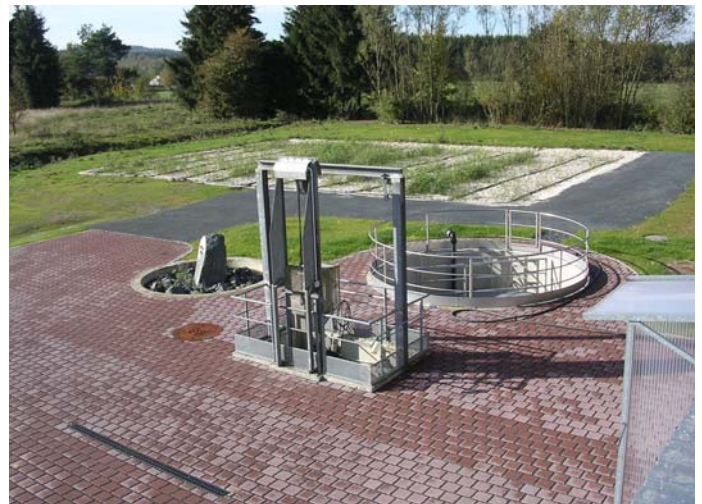
Kläranlage im Oktober 2006
