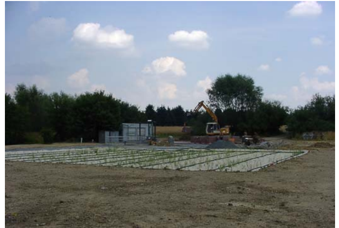
Bodenfilter kurz vor Inbetriebnahme Juli 2006
