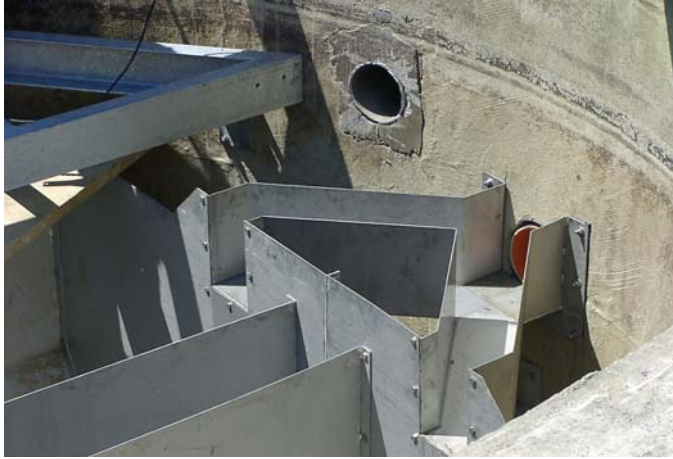
Montage der Einlaufkulissee des zweistraßigen Emscherbeckens
