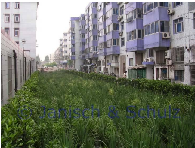
Местная обработка сточных вод в Шанхае, Китай Растительная очистная установка, 80 м 3 /д
