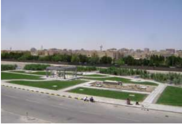
Bu bitkisel su arıtma tesisi tarafından atık su arıtılmakta olup, bir gün içinde de, takriben 100 m 3 sulama suyu elde edilebilmektedir.
