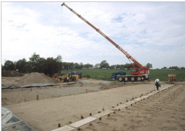
En construcción el primer lecho filtrante / Septiembre 2001
