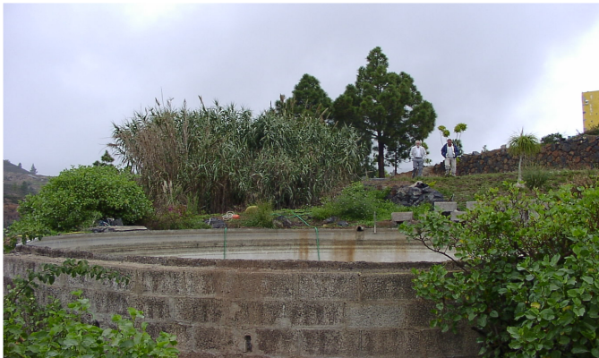
Tratamiento de aguas residuales y reutilización
