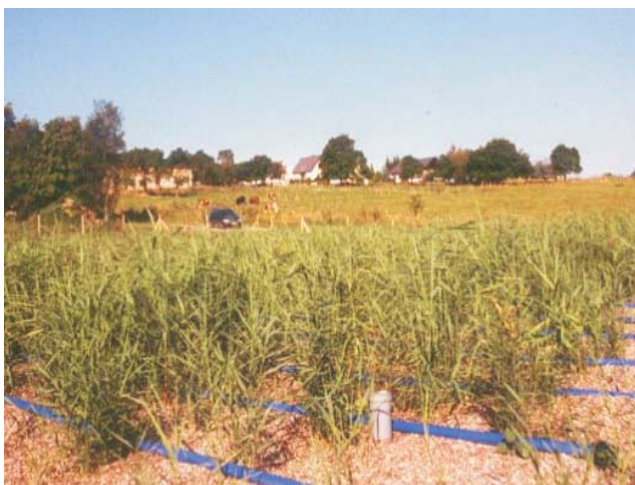
Dorweiler / Alemania , 90 m 3 /d Las aguas residuales percolan el sustrato donde están sembradas las plantas palustres y recorren este filtro.
