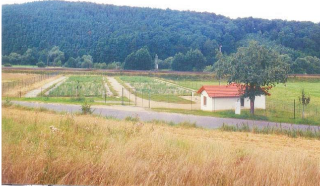
Odensachsen / Alemania , April 2003 Humedales artificiales construída para un max. de 600 habitantes.
