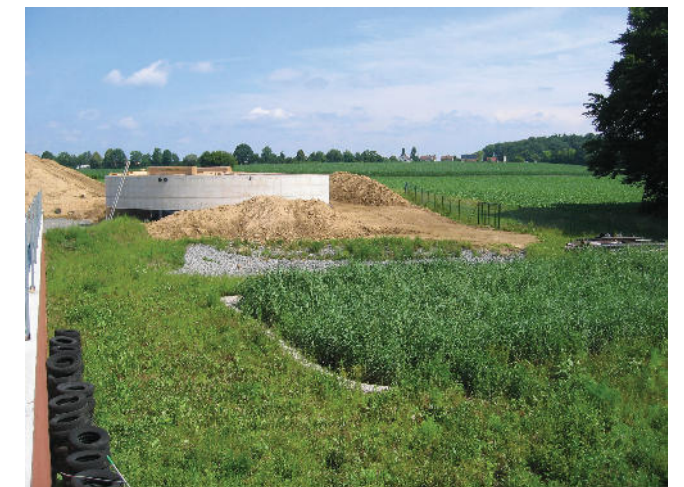
Bad Rappenau, Landkreis Heilbronn, Baujahr 2009 Pflanzenkläranlage zur Reinigung verschmutzter Niederschlagwässer von Siloflächen einer Biogasanlage. Ein Pufferteich kappt hydraulische Spitzen.
