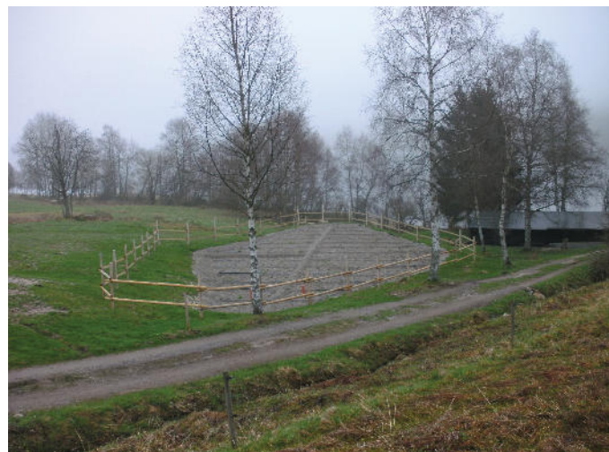
Schluchsee, Landkreis Breisgau-Hochschwarzwald, Bj. 2012 Unmittelbar am Schluchsee gelegen erfüllt die Pflanzenkläranlage am „Unterkrummenhoif“ auch die schärfer geltenden Einleitungsbedingungen.
