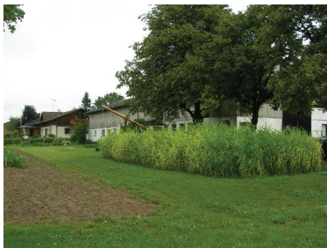
Bissingen, Landkreis Dillingen an der Donau, Baujahr 2005 Abwasserreinigung vor Ort mit Pflanzenkläranlage: Kurze Leitungswege und keinerlei Beeinträchtigung der Wohnqualität.
