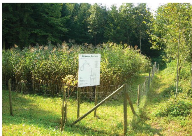
Berwinkel, Rems-Murr-Kreis, Baujahr 2002 Pflanzenkläranlagen als Ortsteilkläranlage rechnen sich. Ohne Fremdenergie betrieben liegen die Re-Investitionskosten äußerst niedrig.
