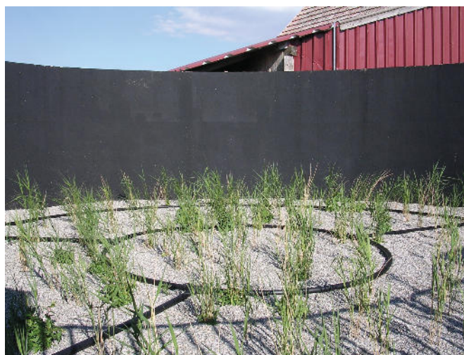
Steinheim, Landkreis Heidenheim, Baujahr 2003 Der ausgediente Güllebehälter als Standort der neuen Kläranlage: Pflanzenkläranlagen können den standörtlichen Bedingungen optimal angepasst werden.
