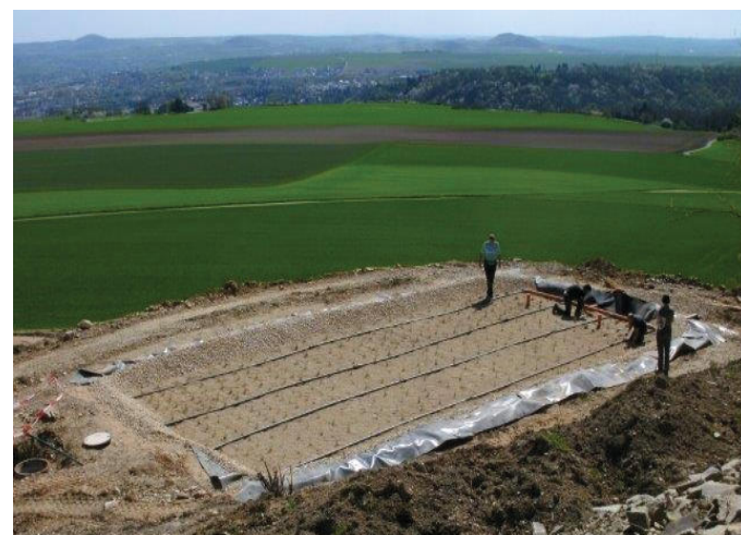
Leutesdorf, VG Bad Hönigen - Baujahr 2013 Pflanzenkläranlage in exponierter Lage - die Brombeerschänke in Leutesdorf nutzt die Topographie des Geländes zur energieautarken Reinigung ihrer Abwässer.
