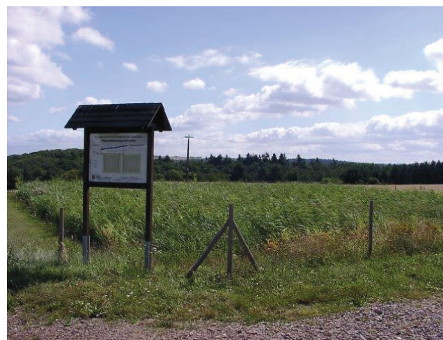
Dorweiler, VG Kastellaun - Baujahr 2001 Diese kommunal betriebene Pflanzenkläranlage wird im Freigefälle täglich mit 90 m³ Abwasser beschickt. Sie arbeitet komplett ohne elektrische Energie.
