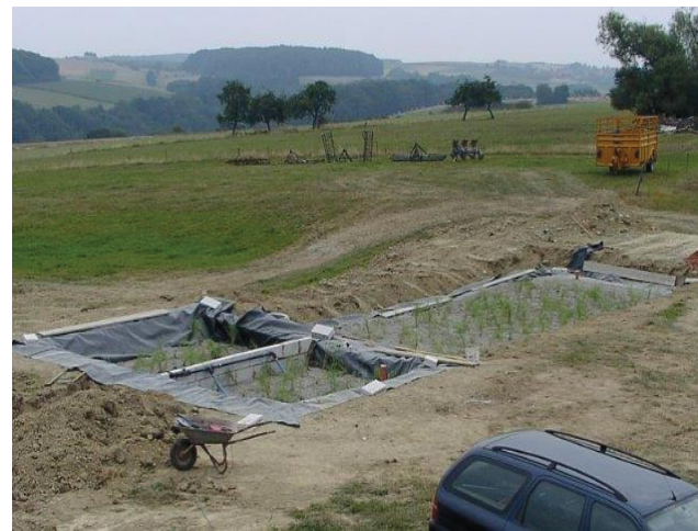
Riedelsberg, VG Zweibrücken-Land, Baujahr 2007 Eine zweiteiliges Klärschlammvererdungsbeet im vorderen Bereich dient der mechanischen Vorreinigung. Es folgt ein Horizontalfilter als biologische Stufe.
