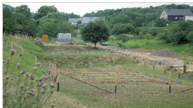
Zdj. Roślinna oczyszczalnia ścieków krótko przed uruchomieniem, czerwiec 2000.
