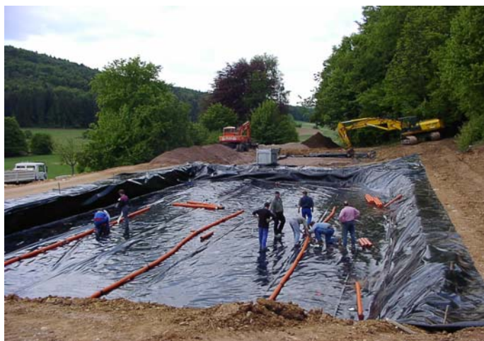
Układanie drenaży – prace własne
