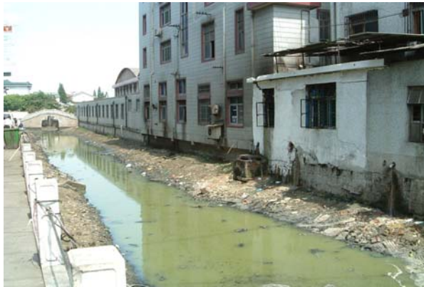
Kanał ściekowy w HuaXin oraz miejsce oczyszczalni ścieków w przyszłości.
