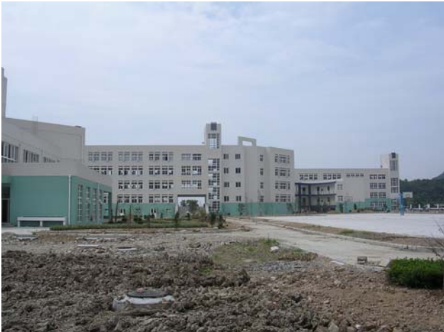
Zdj. Instalacje zewnętrzne w budowie – czerwiec 2004
