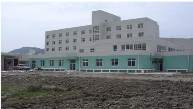
Zdj. Budynek administracyjny – widok ze wschodu
