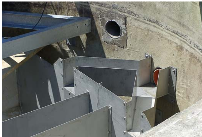
Zdj. Montaż strefy wlotu dwukanałowego osadnika świeżowodnego.
