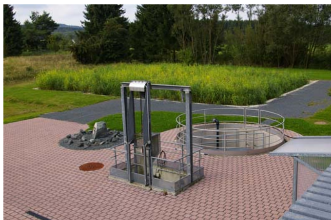
Zdj. Oczyszczalnia ścieków w sierpniu 2007
