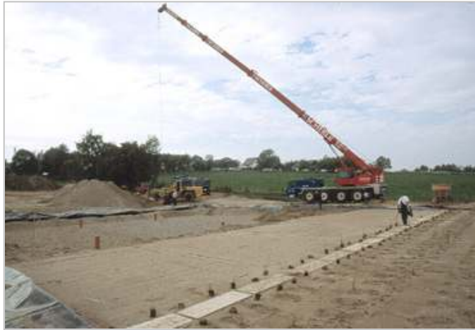
Der erste Bodenfilter im Bau - September 2001
